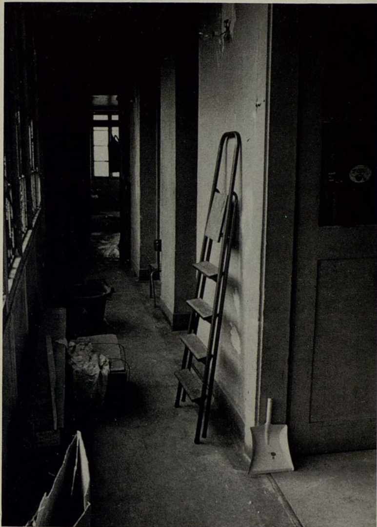
Le foyer : des travaux tout récents
