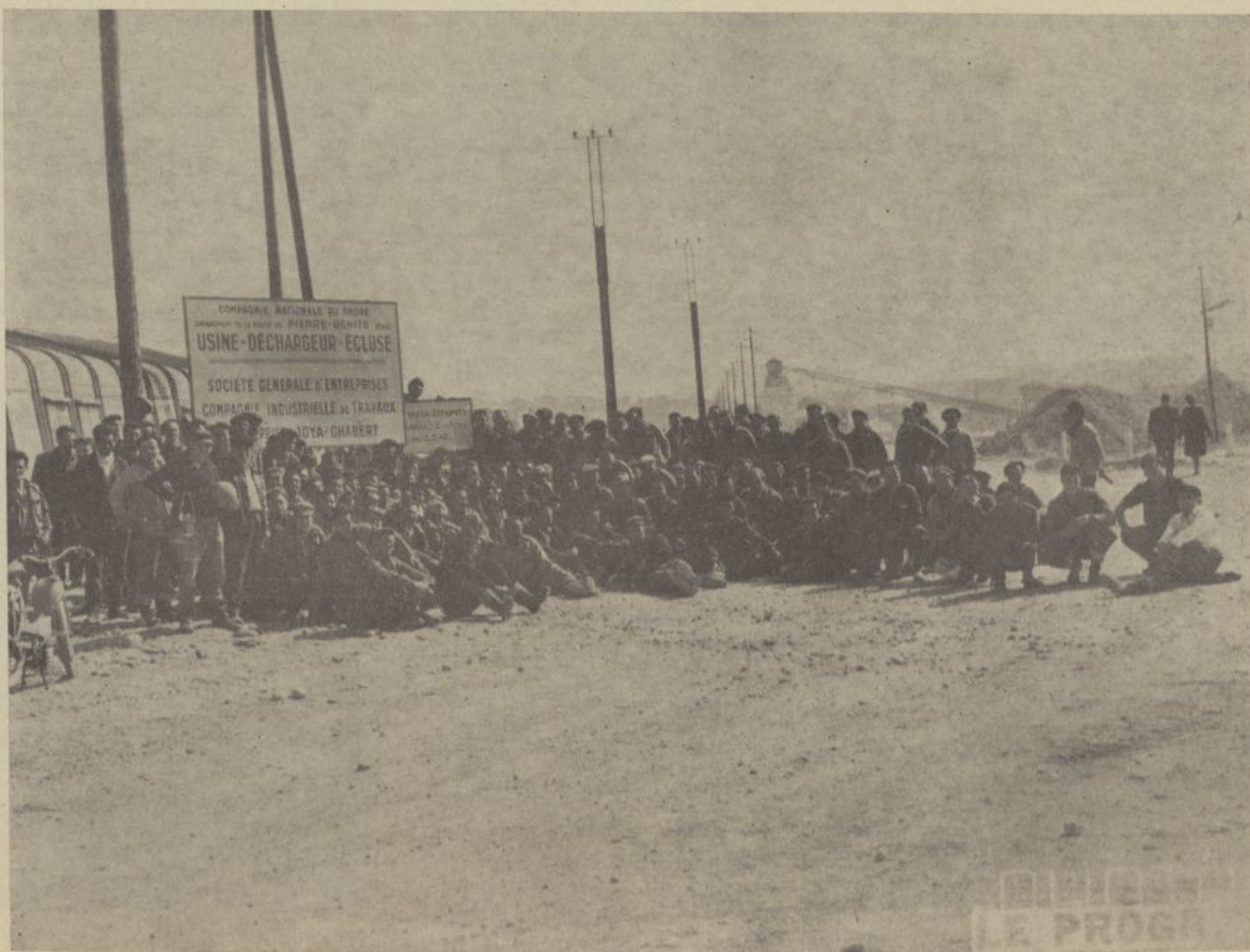
Lavoratori francesi e immigrati in lotta per le loro rivendicazioni sul cantiere di Sbarramento di Pierre-Bénite - Rhône (S.G.E.)
